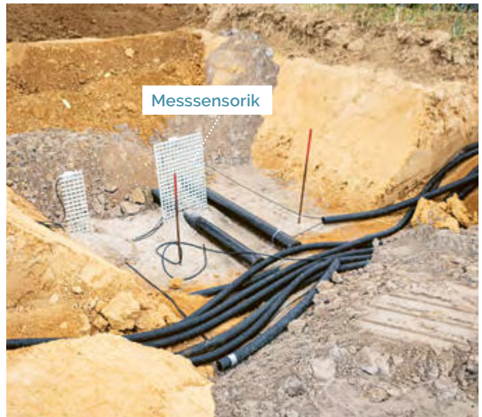
In einem Graben wurden Heizungsrohre installiert, die SuedLink-Kabel simulieren. Messsonden überwachen alle wichtigen Bodenparameter wie Temperatur oder Bodenfeuchte.
