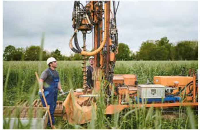
Der Baugrund wurde vor allem dort untersucht, wo SuedLink andere Infrastrukturen wie Straßen, Bahngleise oder Naturschutzgebiete quert.
