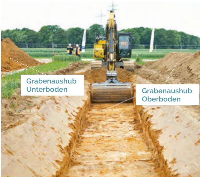
Es wurde ein Graben ausgehoben und wieder verschlossen, um die Auswirkungen des Bodeneingriffs zu ermitteln.
