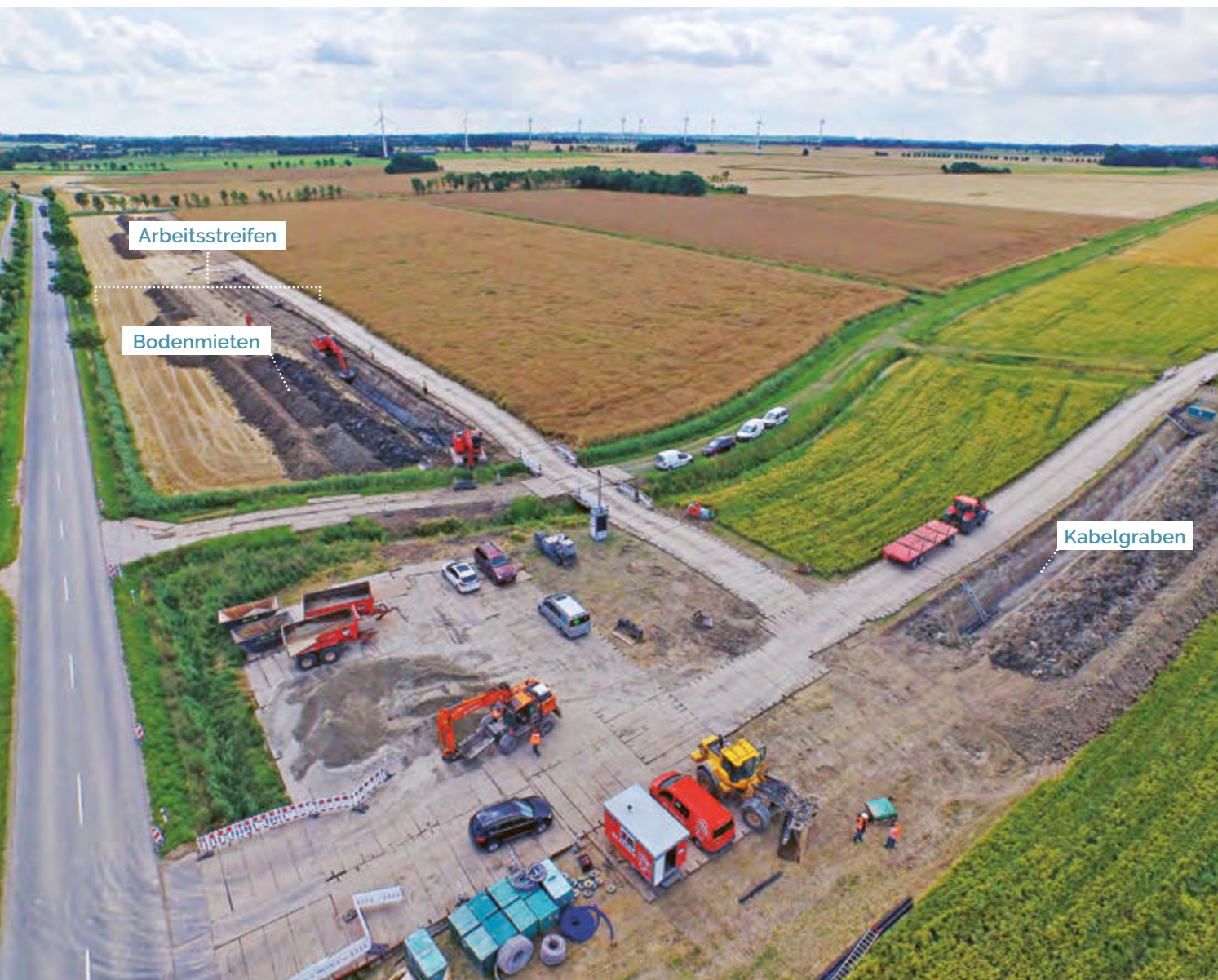
Baustelle bei der Erdkabelverlegung in offener Bauweise.
